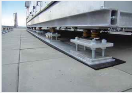
Auf-Dach-Installation einer RLT-Anlage mit höheren Windlasten
