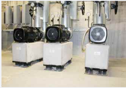
Pumpenlagerung mit zusätzlicher Masse RLT auf Dach installiert
