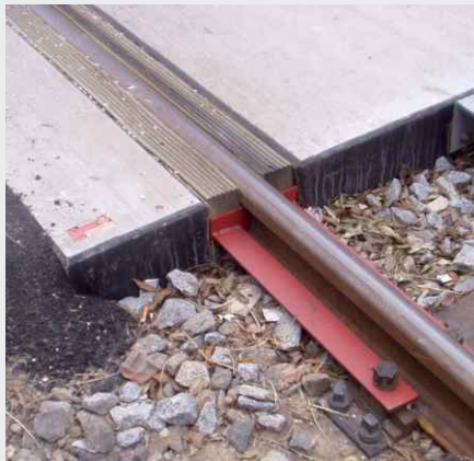
Einbau bei Gleistragplatten
