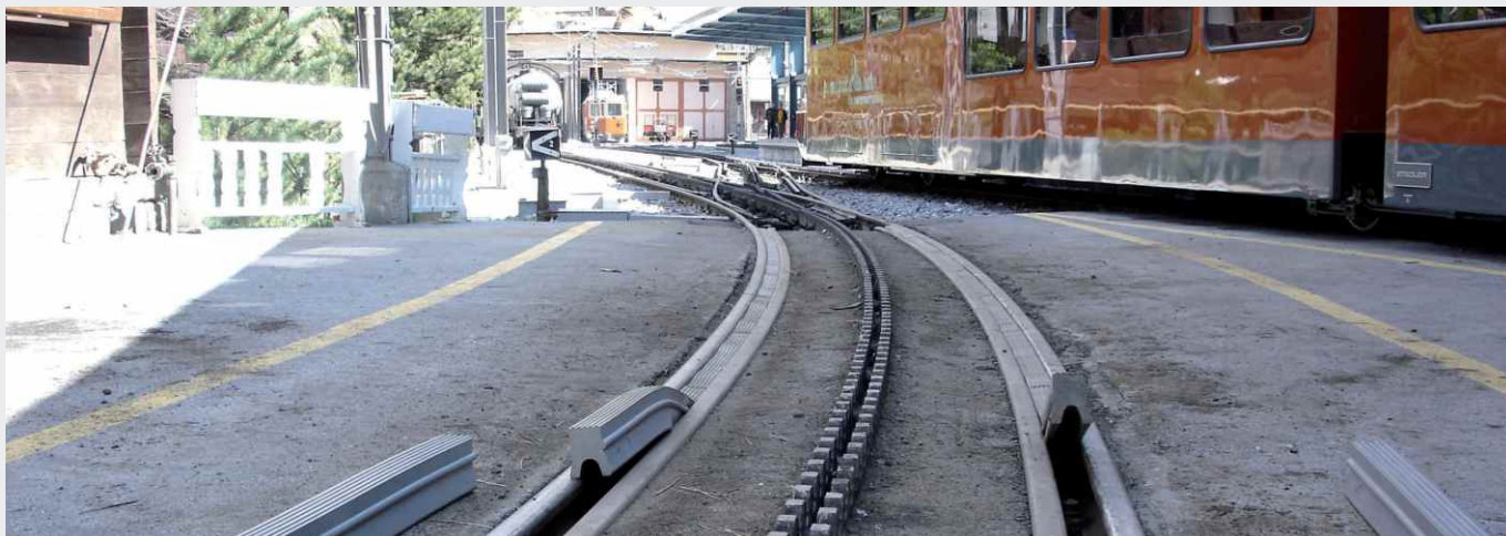
Einfaches Verlegen von Sylomer® Spurrillenfüller
