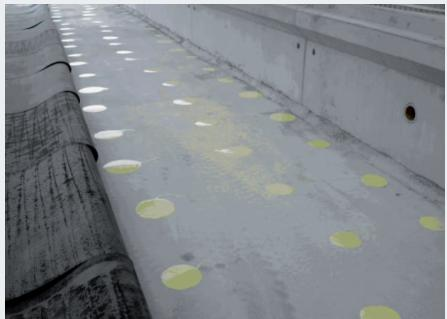
Die USM werden mit der schwarzen Federschicht nach unten quer zur Gleisachse ausgelegt, ausgerichtet und falls erforderlich durch Zuschneiden der Geometrie vor Ort angepasst. Bei extremen Temperaturen bzw. Temperaturdifferenzen oder nach längerer Lagerung sollten die USM zuerst ausgelegt werden und vor der Verklebung einige Zeit (mehrere Stunden) ruhen, damit sich mögliche Verformungen im Material entspannen können. Danach erfolgt die Verlegung wie beschrieben.
