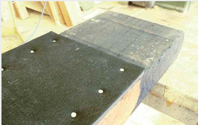
Bei der Anbringung der Schwellensohle mittels Nägeln ist darauf zu achten, dass die Federschicht der Schwellensohle direkten Kontakt zur Holzschwelle hat. Weiters ist zu beachten, dass die Nägel die Geotextil-Schutzschicht nicht beschädigen.
