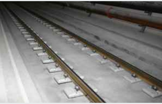
Feste Fahrbahn mit LVT-System
