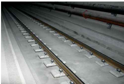
Feste Fahrbahn mit LVT-System
