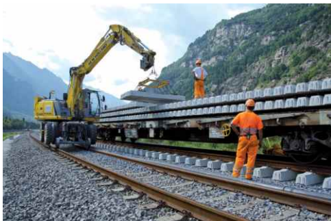
Zufahrtsstrecken mit Schotteroberbau
