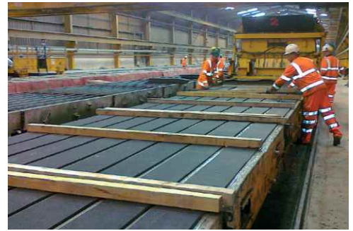
Vormontage der Schwellensohlen im Werk
