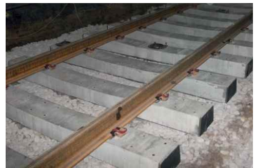
Einbau im Tunnel
