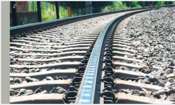
Schiene mit Schlupfwellen
