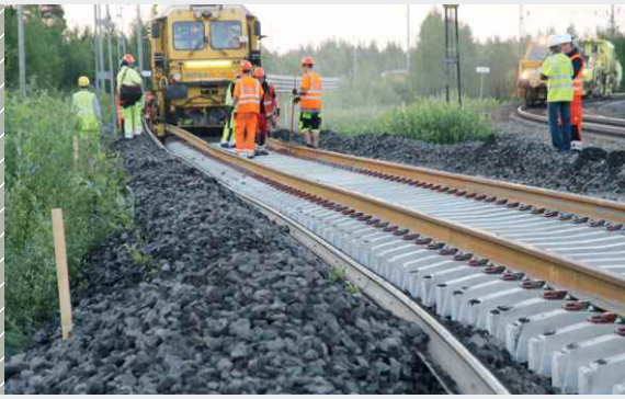
Einbau besohlter Schwellen auf der Strecke Malmabanan
