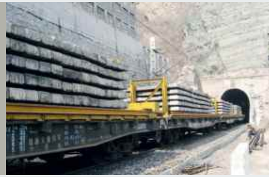
Besohlte Schwellen für die Fengsha Linie
