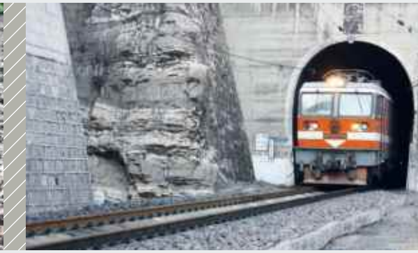
Tunnel auf der Fengsha Kohlelinie in China
