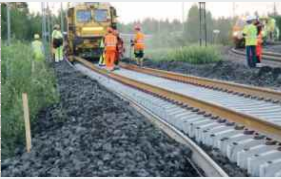
Einbau besohlter Schwellen auf der Strecke Malmabanan
