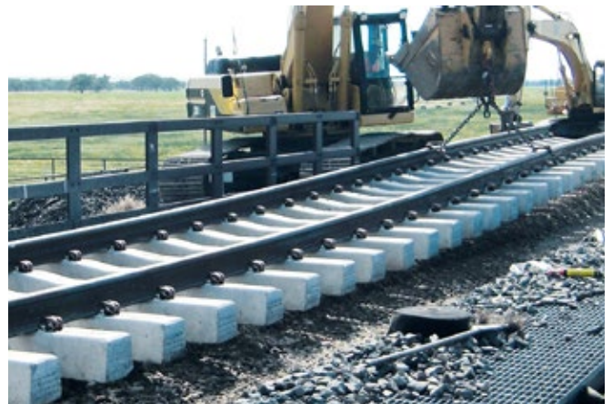
Einbau von Unterschottermatten auf einem Streckenabschnitt von Union Pacific in den USA
