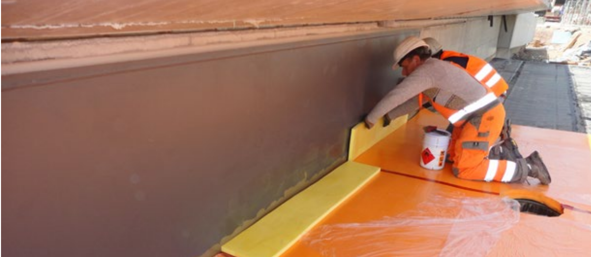
Verlegung Masse-Feder-System
