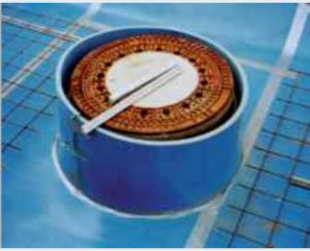
Isolation eines Masse-Feder-Systems gegenüber einer Kanalleitung
