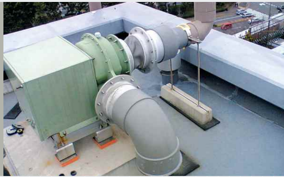
Vibrationen effizient eindämmen: Entkopplung Pumpe und Rohrleitung
