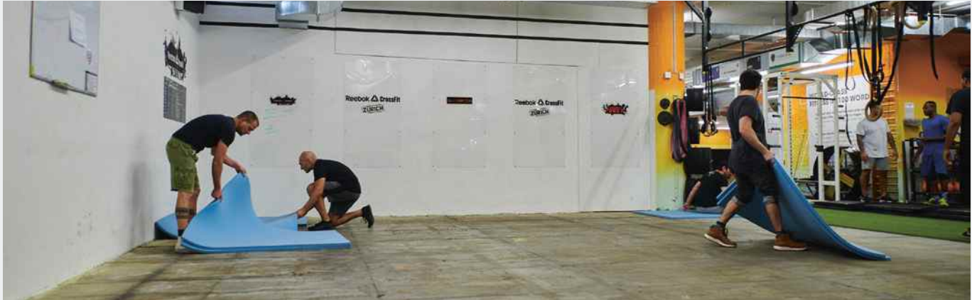
Eric Diaw & Team bei der Verlegearbeit
