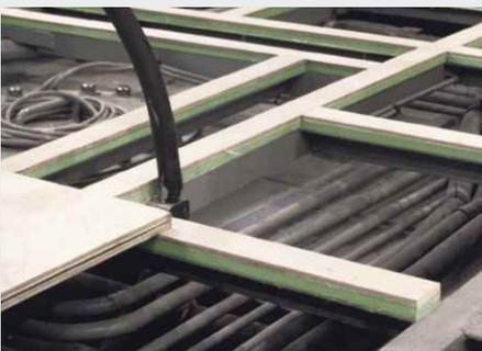
Sylomer®-Streifen entkoppeln den Schiffboden und sorgen für mehr Komfort.
