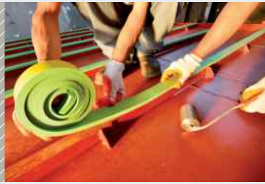
Anbringen der Vibrationslagerung mittels Sylomerstreifen
